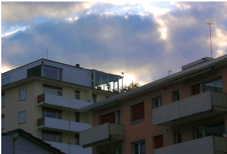
Bauvisiere für die beiden Mobilfunkantennen an der Rosgartenstrasse 3 (vorne) und an der Emil-Bächler-Strasse 3 (hinten).
